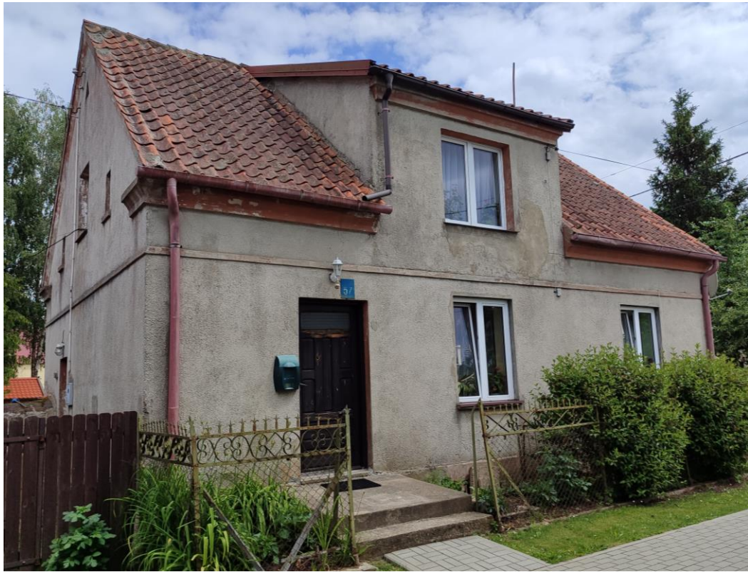
Murowany budynek mieszkalny nr 57 w Biesowie, z początku XX w. Fot. A. Żabińska
