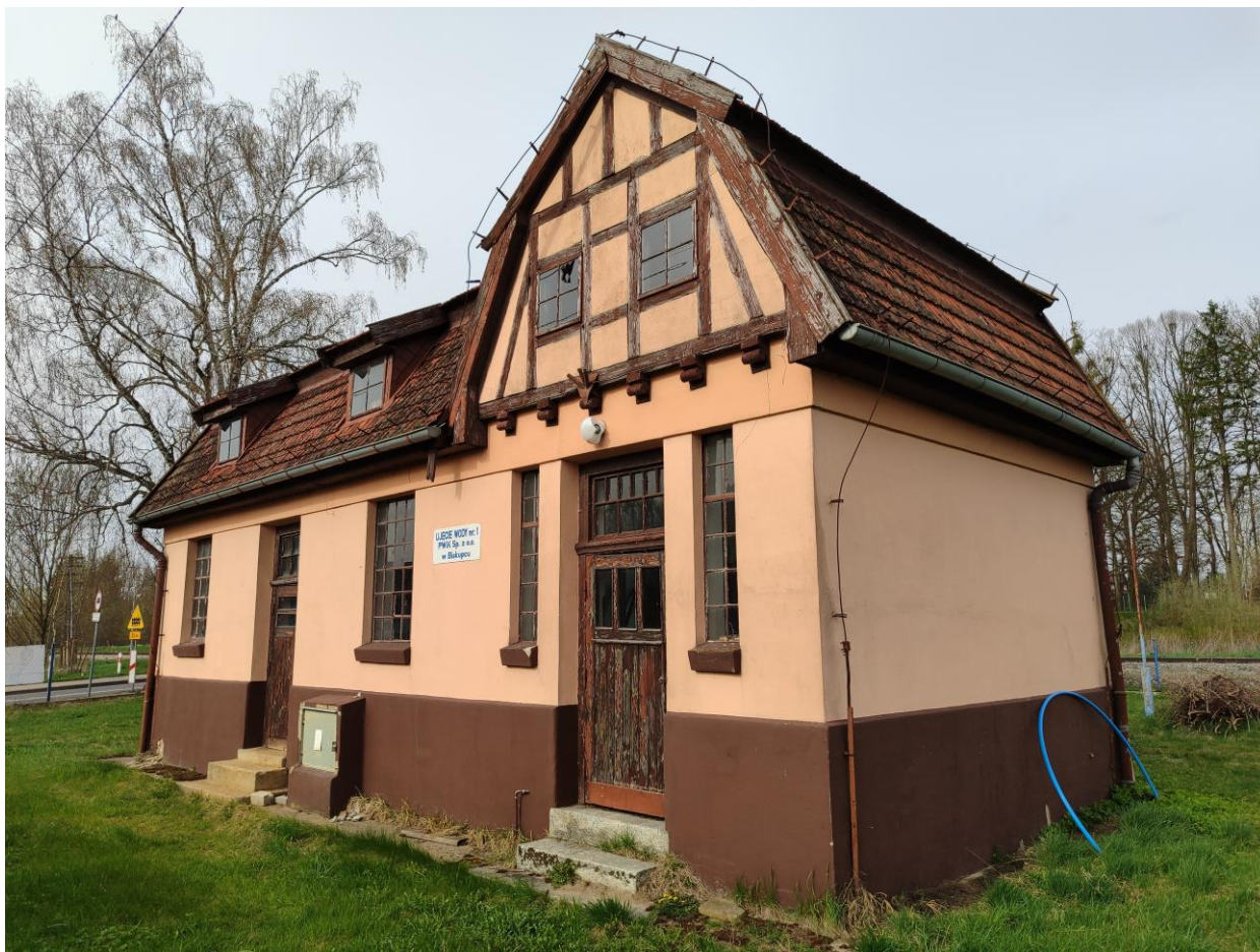
Biskupiec. Stacja pomp w zespole ujęcia wody z lat 192-1913. Fot. A. Żabińska
