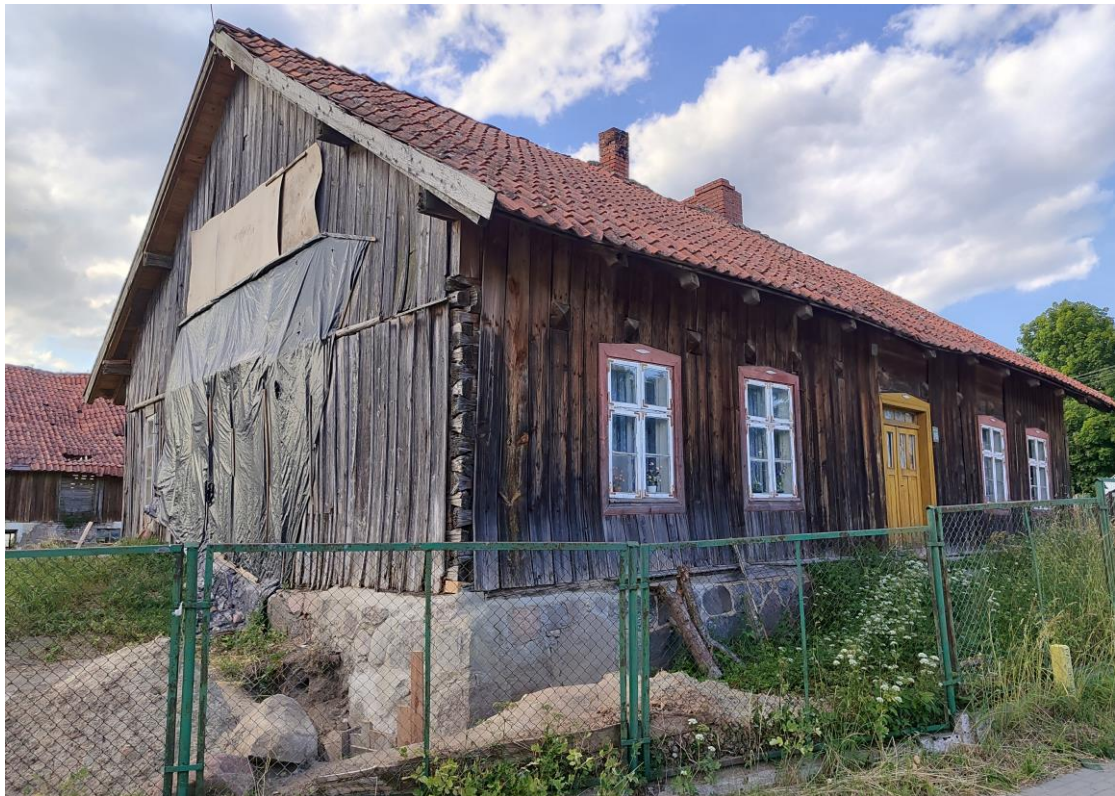
Drewniany budynek mieszkalny w Stryjewie z końca XIX wieku. Fot. A. Żabińska
