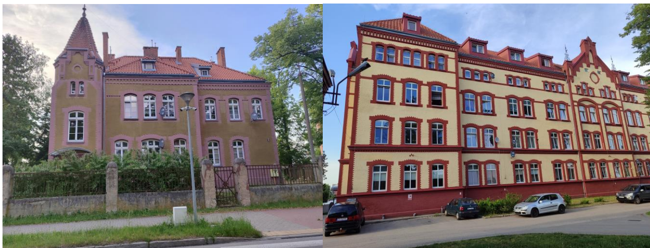
Budynki dawnych koszar wojskowych, z lewej budynek przy ul. Wojska Polskiego 12, z prawej budynek przy ul. Aleja Broni 1c. Fot. A. Żabińska
