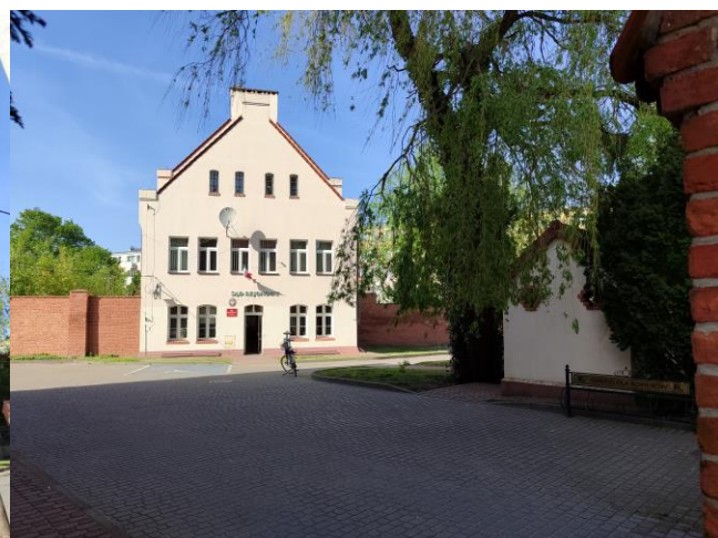
Budynek sądu przy ul. Sądowej 2 widoczny od strony południowo-zachodniej. Fot. A. Żabińska
