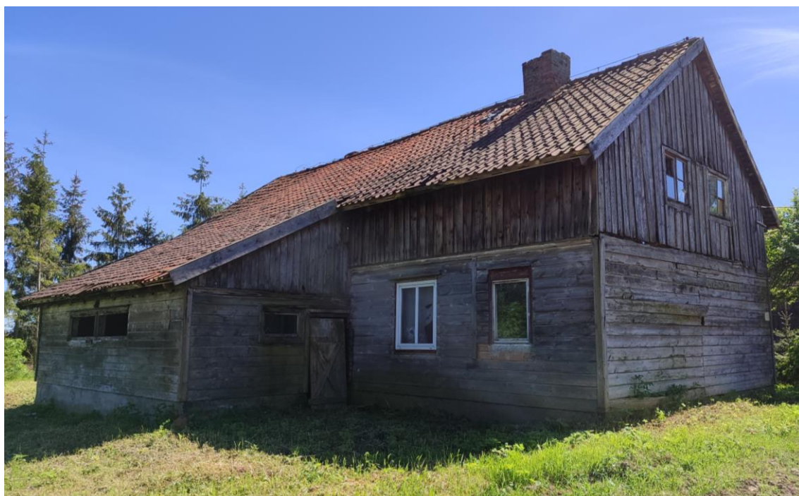
Drewniany budynek mieszkalno-gospodarczy w Kobuľach 73 z przełomu XIX i XX wieku. Fot. A. Źabińska
